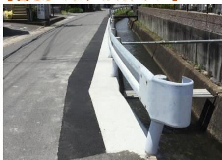
千代川町小川の水路の嵩上げ工事が完成し、歩行者が車を避けようと水路側によった時、水路へ足がずり落ちる等の危険が解消されました。(H30.6)
